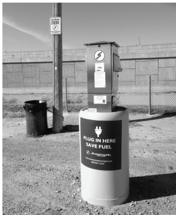
Рис. 3. Оборудование для подключения автопоезда к электросети на паркинге Newell Travel Plaza, г. Ньютон, штат Канзас, США [6]
